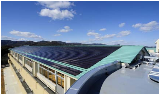
校舎屋根に太陽光パネルを設置
