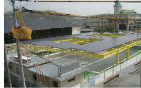
紫外線対策を兼ねてプールの屋上に設置された太陽光発電パネル。
