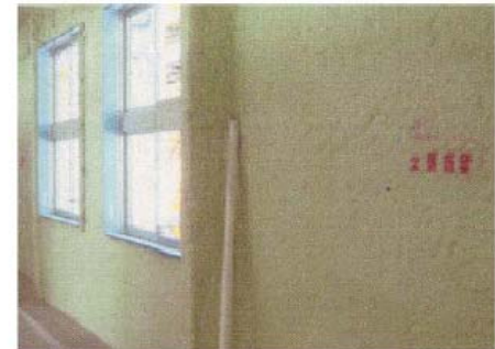
フレタン吹き付けによる内断熱。
