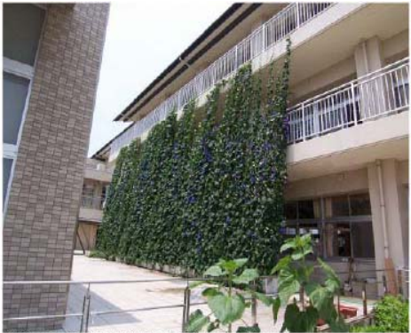
南側には、琉球アサガオによる壁面緑化を設置。
