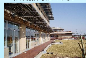
(東京都・武蔵野市 大野田小学校) 21KW
