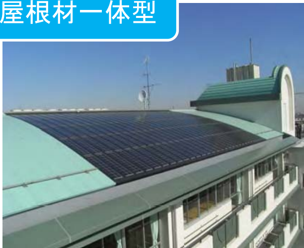
埼玉県和光市立新倉小学校
