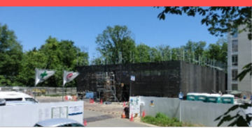
建設工事の様子
