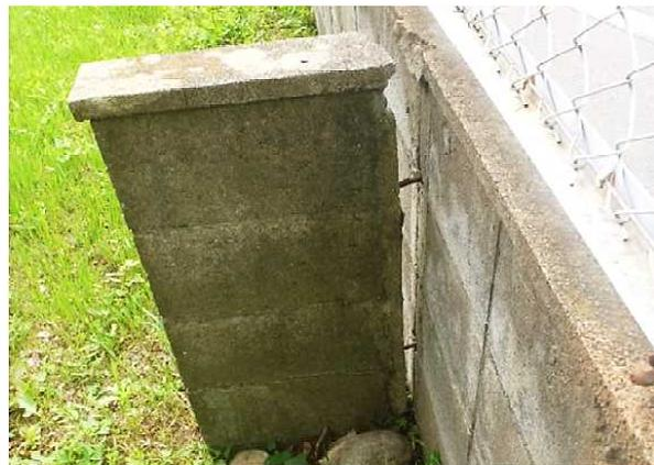
写真4. 控え壁の損傷
