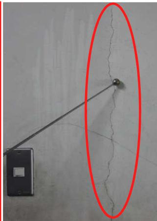
写真5. 内壁のひび割れ
