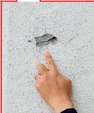
写真4. 外壁の浮き、剥落
