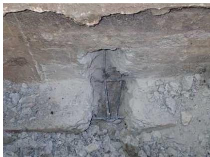
写真2. 配置する鉄筋の状況確認
