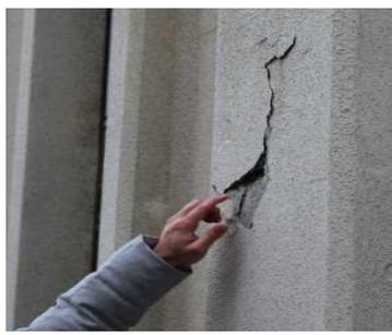
写真1. モルタルの剥落
