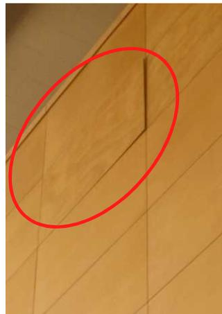
写真6. 内壁のずれ
