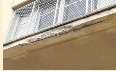
写真4. コンクリートの爆裂
