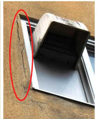
写真7. 外壁のひび割れ
