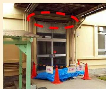
写真1. 赤破線部分にあった庇が落下
