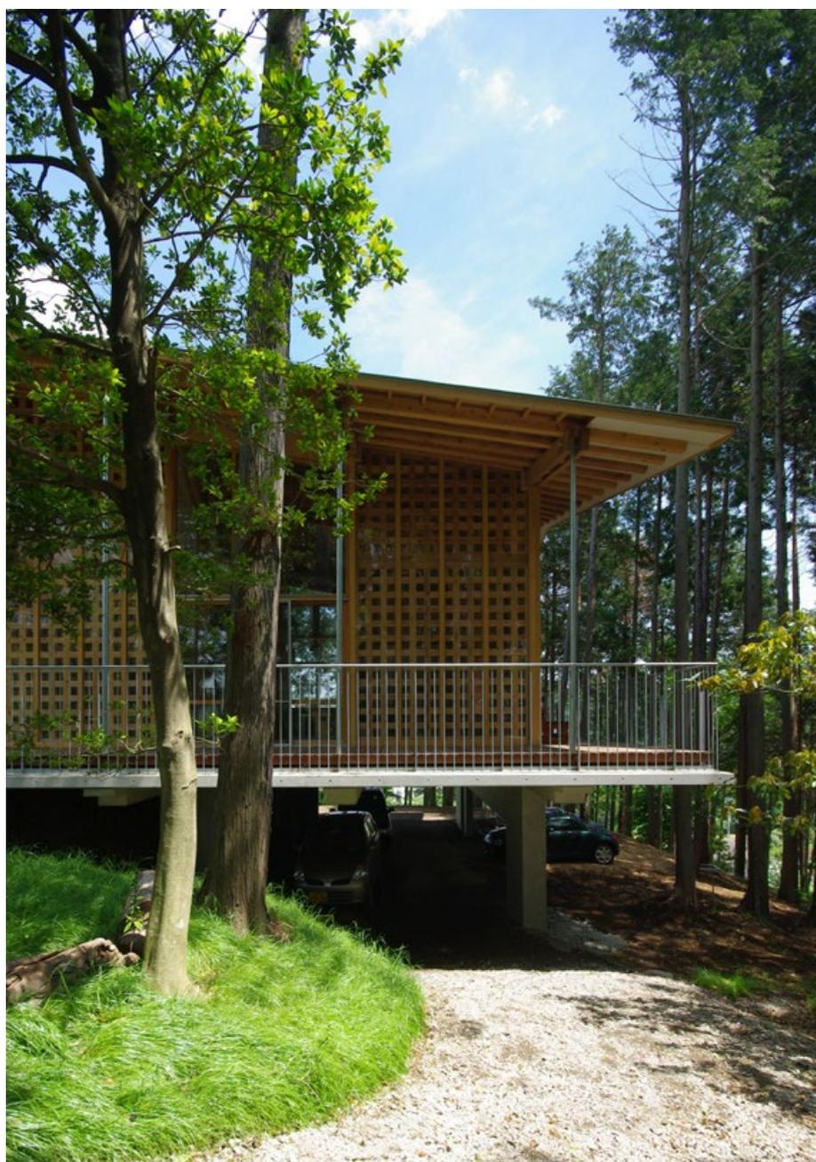
図 16 模型で敷桁を丸太とするか検討。内外の連続性を重視し、細角材とした。
