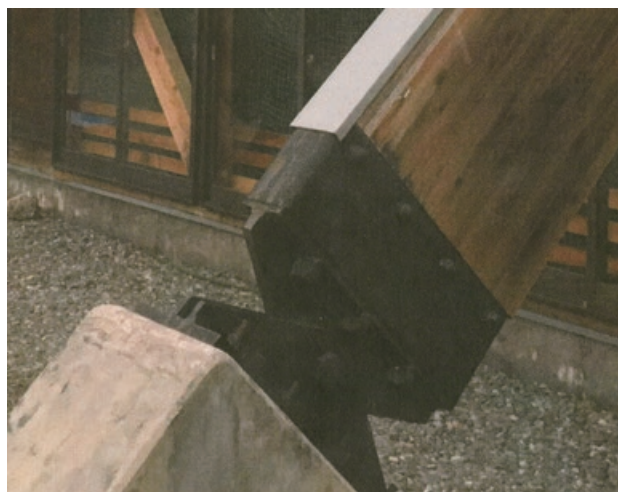
図 7-9 アーチ集成材脚部と接合金物
