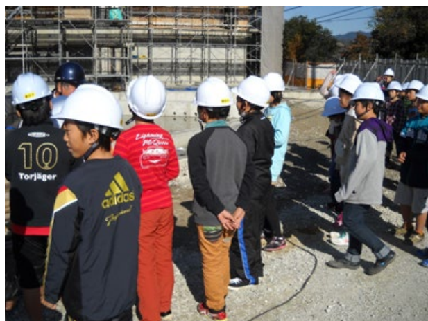
図 6-5 児童の建築現場の視察（躯体工事時）
