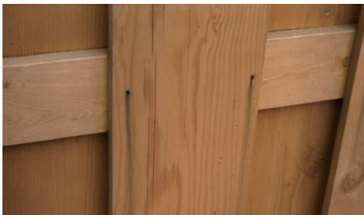
図 7-18 釘からの鉄汚染の例
