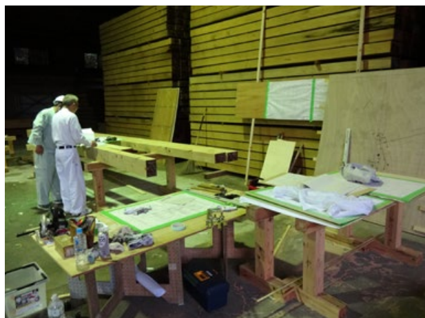
図 6-4 大工による墨付け作業
