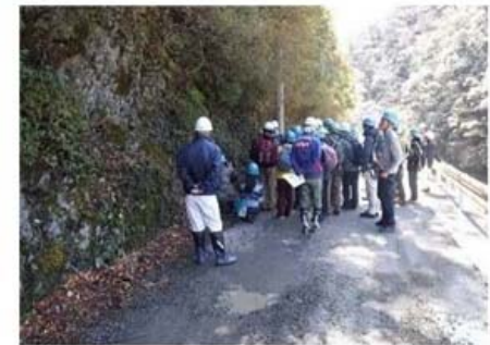
崩壊に寄与した破碎帯の説明風景
