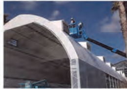
図 排煙窓取付 出所：亀井(2013)
