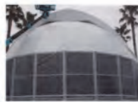
図 半球部分のシート取付 出所：亀井(2013)
