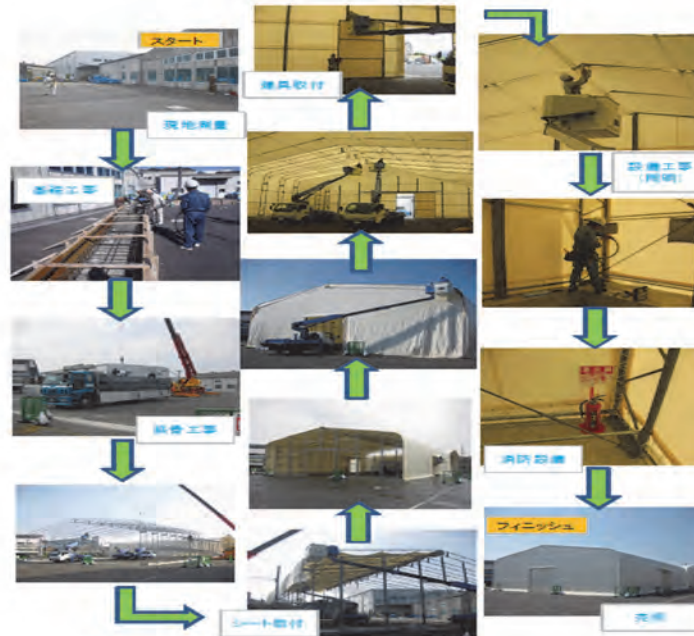
図 産業用テント現場工程 出所：亀井省吾(2013)
