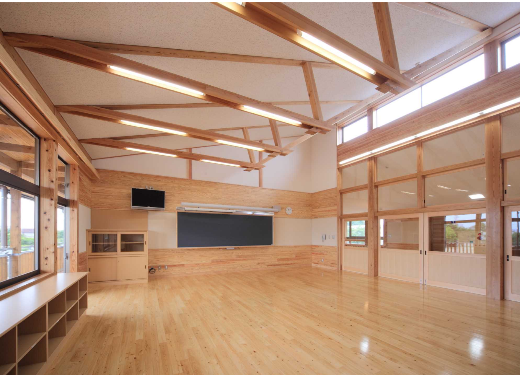
2階普通教室 木製張弦トラス
