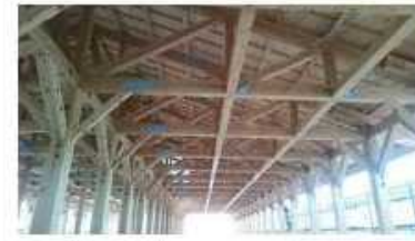
16.小屋裏状況(水平ブレース)
