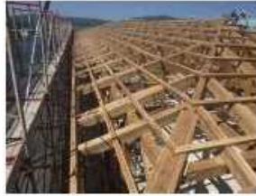
10.小屋組み、母屋取付け
