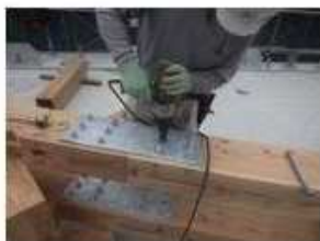
3.継手ボルト締め
