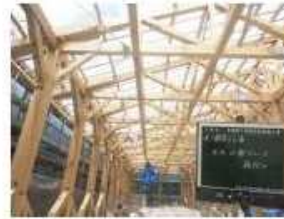
14.小屋ブレース取付け
