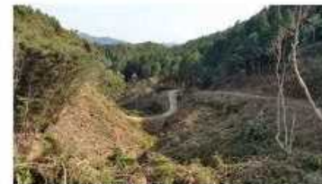
18.伐採搬出完了
