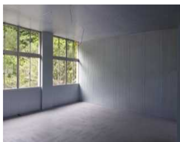
各教室を断熱材で施工し、より気密性の高い部屋として改修。温度・湿度調整が容易で菌床の管理がしやすい施設となった。
