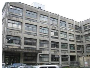
耐震性の低い施設の外観
