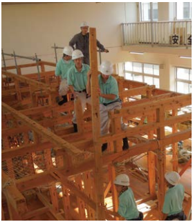
建築に関する学科の木造住宅を建てる実習
