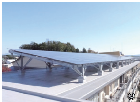
写真 ①外観（改修後）②外観（改修前）③屋上に設置した太陽光発電パネル
