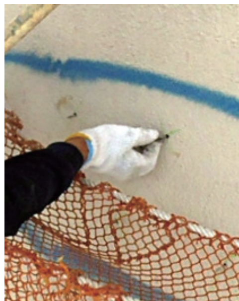
モルタルの浮きを躯体に確実に固定するためアンカーピンを挿入
