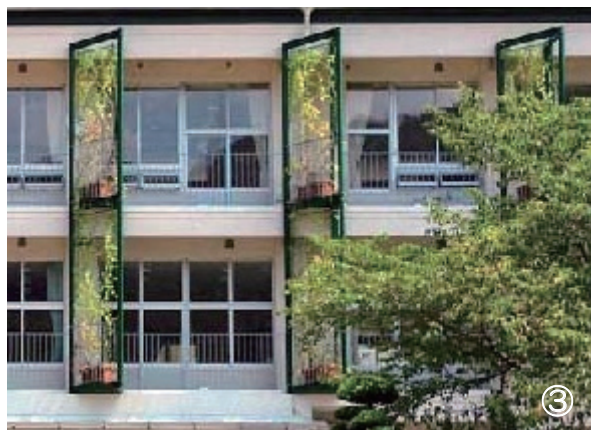
写真 ①外観（改修後）②外観（改修前）③エコフレーム（イメージ図）
