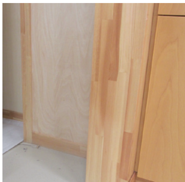
補修完了後に木仕上げを実施
