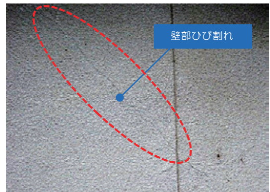
外壁の劣化状況
