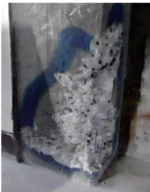
欠損部分のまわりをはつりとした状態
