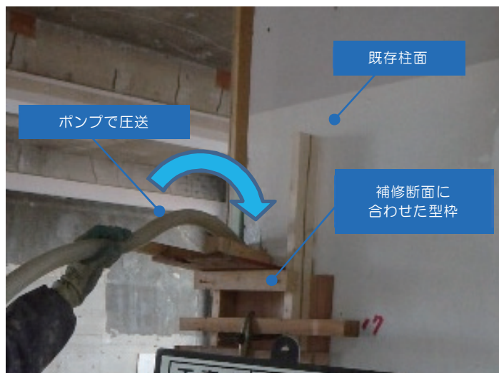
型枠を組み、充てん剤を充てん中
