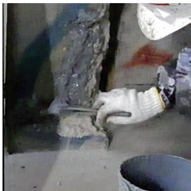
モルタルの付着を良くするための下地材を塗布
