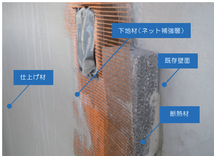
コンクリート躯体に断熱材を接着させ、仕上げ材を施工（断面）
