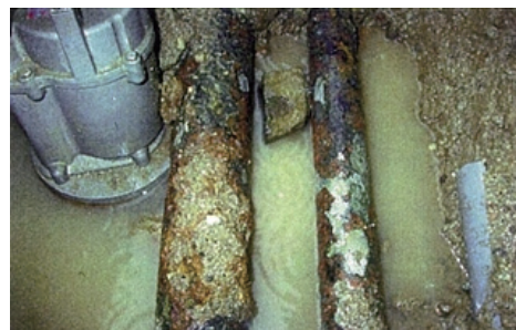
腐食により漏水した埋設配管
