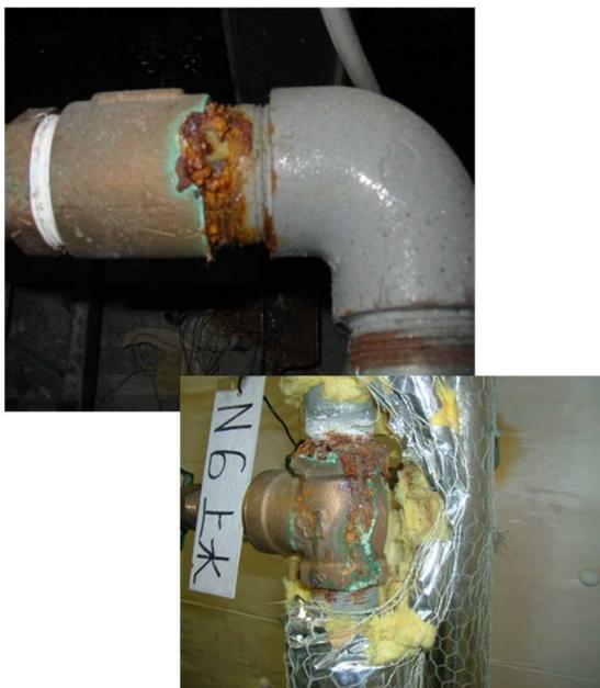
給水管継ぎ手の劣化状況
