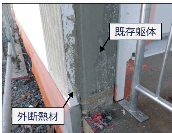
施工例（鳥取小学校）
