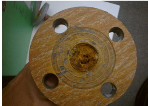
給水管の閉塞状況
