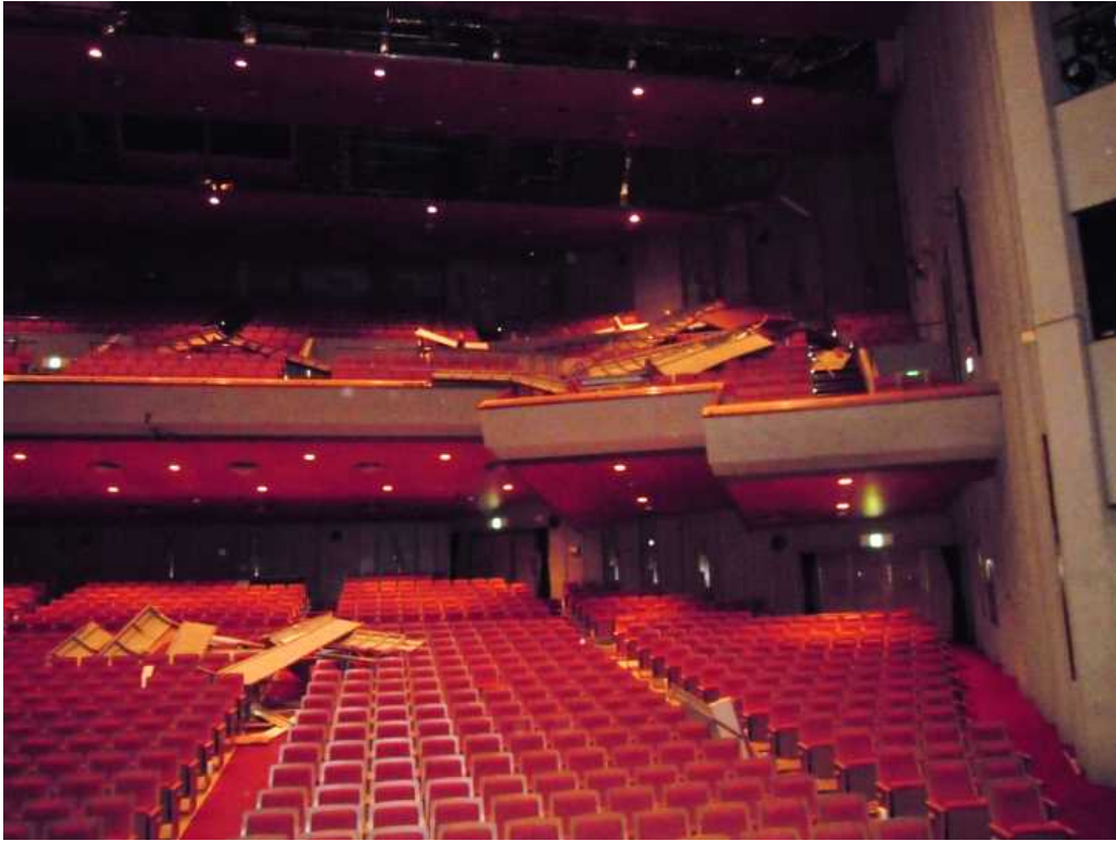
(3.11福島県民ホール天井落下)
