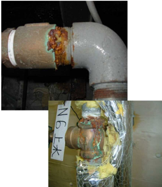
給水管継ぎ手の劣化状況
