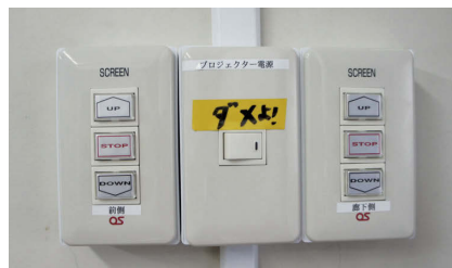
▲スクリーンの昇降やプロジェクタの電源は教室内に設置されたスイッチに集約され、簡単に準備ができる
