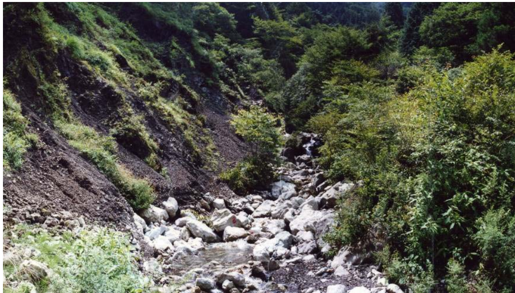
施工前の状況
