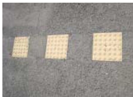
町田市独自の敷設方法
