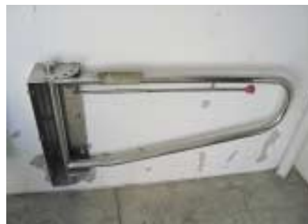
初期の改修事例で見られたスイング式の手すり
