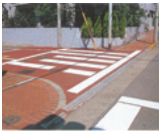
梅丘地区の歩道の整備 (車道と歩道の段差解消)
