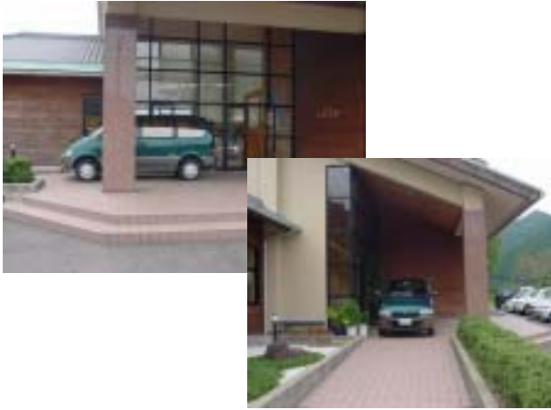
三重県紀伊長島町立赤羽中学校
