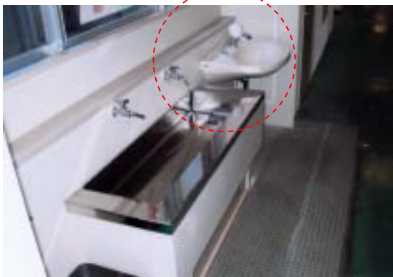
固定式洗面台の事例
