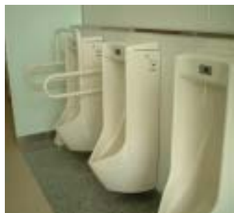
壁掛式低リップの事例 島根県松江市立母衣小学校
