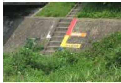
大きな川にある水位観測所
