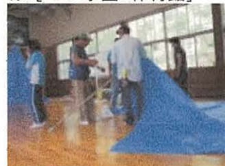
仮設テントの設営
