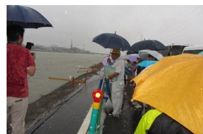
河川工事の様子の見学
