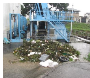
ポンプ場にたまるゴミの様子
