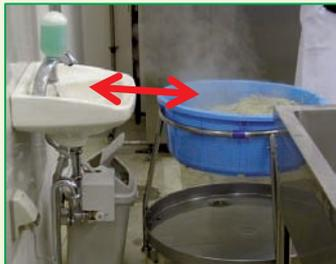
手洗い設備と食品取扱い場所が近いと、手洗い時の洗浄水が食品に飛散します。
