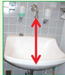
蛇口が高すぎると、周囲に洗浄水を飛散させる原因となります。
