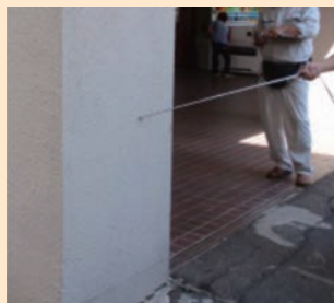
写真1. 打診調査状況
