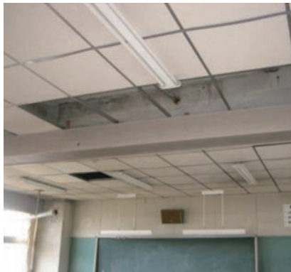
写真2. 梁際の破損
