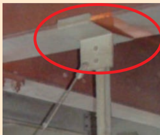
写真1. クランプ類の滑りの例 2)
