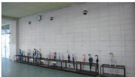
写真1. コンクリートブロックによる外壁の例
