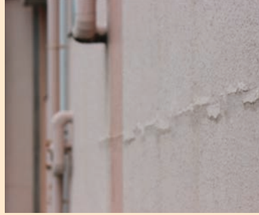
写真 2. 塗料の浮き
