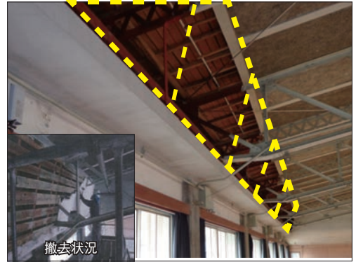
写真1. 下がり壁（点線で囲った部分）撤去後
