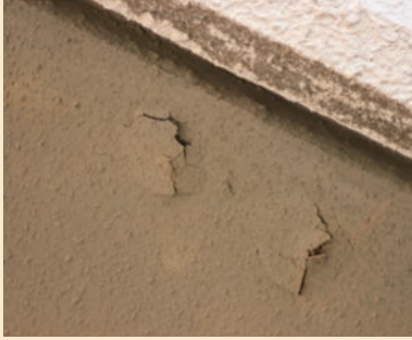
写真 1. 塗料の浮き
