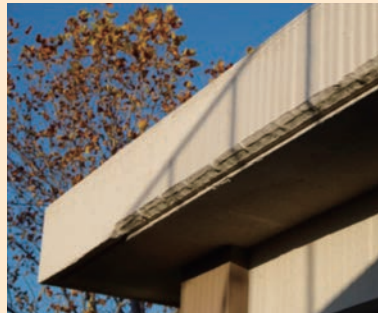
写真 4. 補修例（はつり後、塗装仕上げ）
