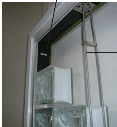
写真3. 現在の工法による施工状況 12)
