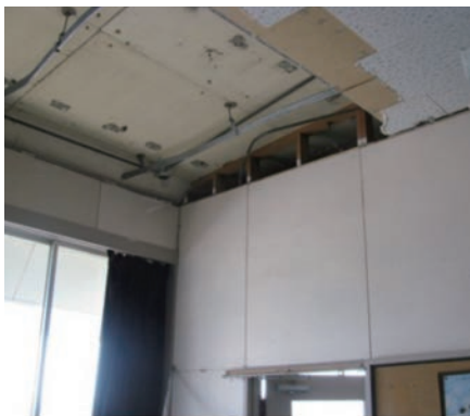
写真 1. 壁際の破損
