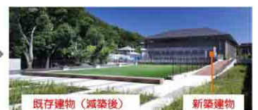
手前：既存建物（減築後）
