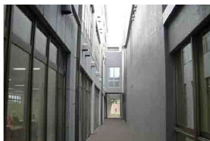
既存棟と増築棟を接続するクレバス
