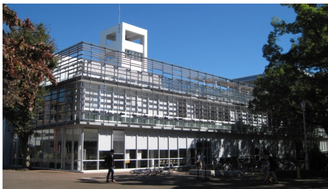
附属図書館本館L棟南側外観
