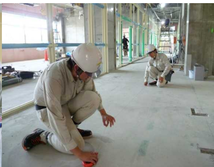
建築現場での墨引き作業
