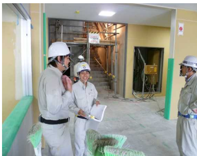
建築現場での作業前の打合せ
