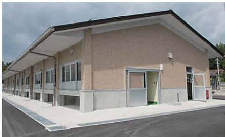
再建したカキ処理施設(東松島市)
