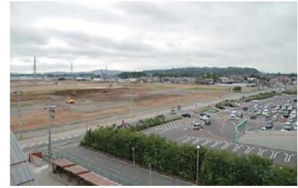
新蛇田地区造成工事の状況(石巻市)
