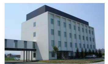
創薬基盤技術研究棟 (北海道大学)
