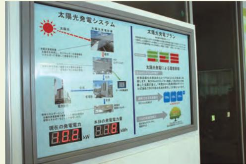
屋上に設置された太陽光発電パネル。これまで段階的に増設し、20kwの出力で普通教室21室の照明をまかなうことができる。発電量をエントランスホールのパネルに表示している。(雲雀丘学園中学校・高等学校)
