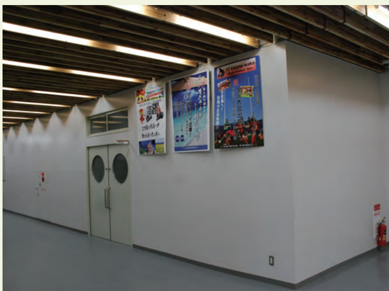
廊下の天井のルーバーに地元産の木材を使用した例。(和歌山県立和歌山工業高等学校)
