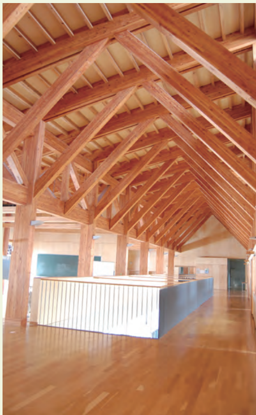
大断面集成材を使った構造体が表されていることにより、躍動感が感じられるホール。(秋田県立横手清陵学院中学校・高等学校)
