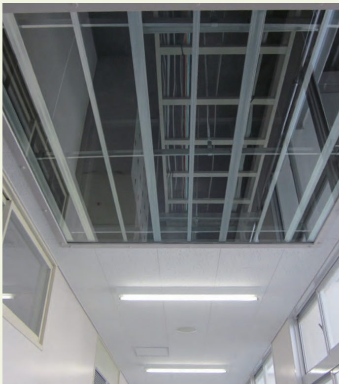
天井の一部を透明にして、内部の配線・配管を見られるようにした例。 (和歌山県立和歌山工業高等学校)
