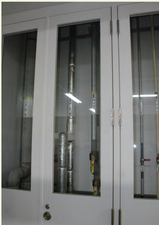
廊下に面したシャフト（配管スペース）の扉にガラス窓を付けた例。縦に貫通する配管にも説明を記している。 (静岡県立科学技術高等学校)
