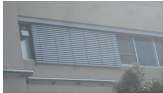
外付けブラインドを設置することにより、通風を確保しつつ、西日による強い太陽輻射熱の室内への侵入を遮る
