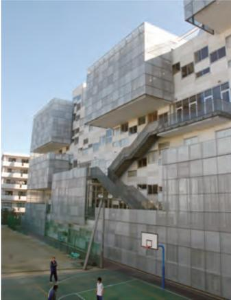
ダイナミックに飛び出している部分は、ガラスのカーテンウォールと、その外側の防球機能をかねたパンチングメタルで覆われている。それぞれの上部はテラスとして活用されている。
