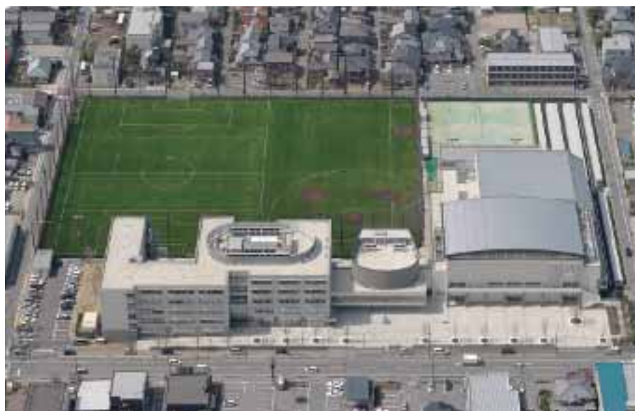
全景。学習施設と運動施設をL字に配置し、グラウンドを広く造っている。
