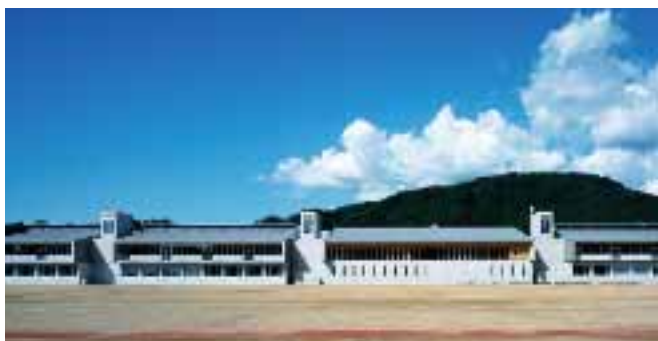
12 煙突のようにみえるのが自然換気を促すソーラーチムニー。
