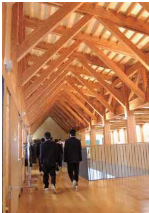
1 南棟2階東側。大断面集成材の木架構が連続し、木のぬくもりあふれる空間のなかで学ぶことができる。
