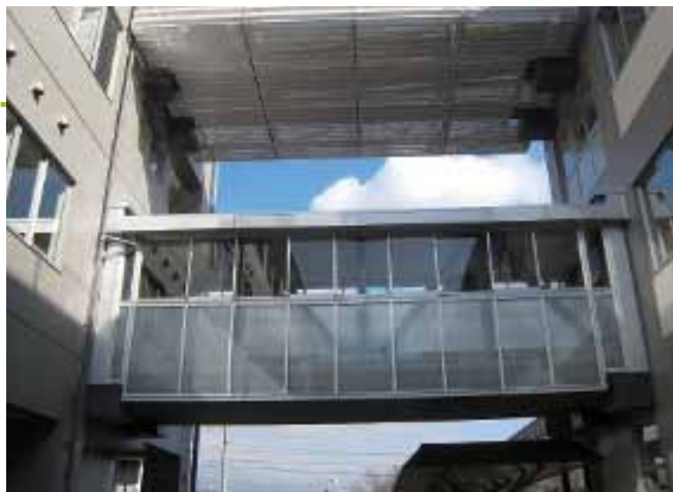
5 管理棟と看護棟を結ぶ合理的な回遊動線を構成するブリッジ。
