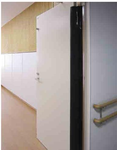
③ ドアの開閉時に児童生徒が隙間に指を挟まないよう、隙間にはラバーが装着されている。
