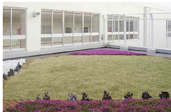
⑤ 屋上庭園は、児童生徒が屋外に出てくつろげる空間になっている。自動灌水装置の導入により、管理負担を軽減している。上部を折り返したフェンスを設置し、安全面にも配慮している。
