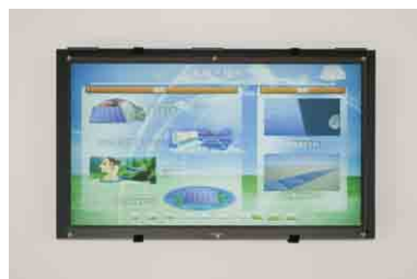
⑧ 昇降口前の電子ボードは、太陽光パネルの発電量を示すほか、太陽光発電に関する解説も表示している。
