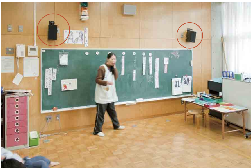
④ 教室ではFM補聴システムを採用している。教員はペンダント型のマイクを使用して指導を行っている。スピーカーも併用でき、児童生徒に聞こえやすいように角度が調整されている。
