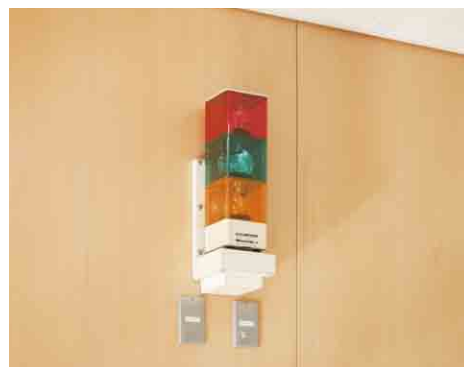
⑤ 普通教室の黒板の上にはカラーランプを用いたチャイムが設置されていて、視覚的に状況が把握できるようになっている。
