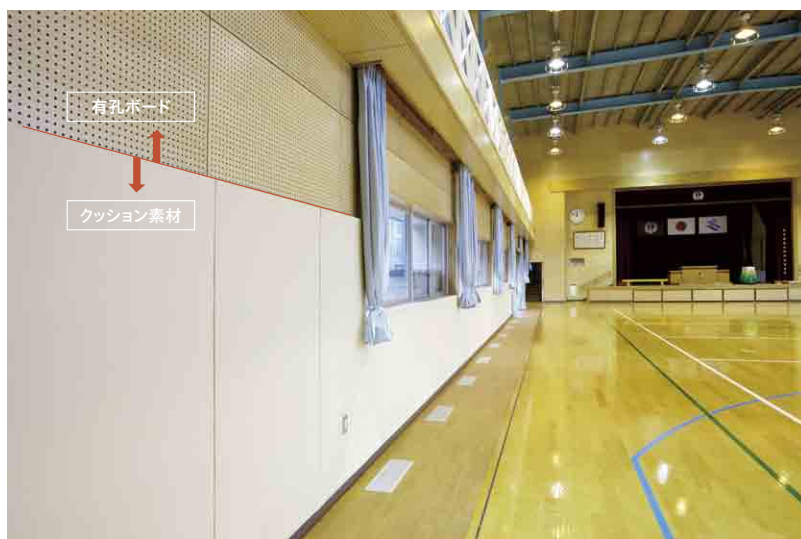
⑨ 体育館の壁を有孔ボードにすることで、音の反響を抑える工夫をしている。また、壁の下部をクッション性のある素材で覆うことで、安全面にも配慮している。
