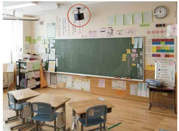
⑦ 聾学校の各部屋には、集団補聴システムが設置されている(赤囲み)。小学部以上の教室では、赤外線補聴システムを、幼稚部では磁気ループ式補聴システムを採用している。
