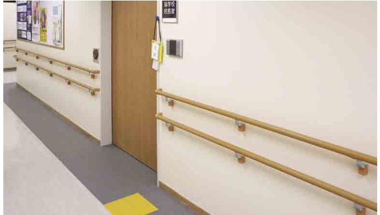
⑤ 盲学校には、廊下の両側に足の裏で感触がわかる細かい凹凸のあるグレーのラバーと手すりが設置されている。各部屋の出入口下には点字ブロックを設置するとともに、室名を手すりに点字で表記している。
