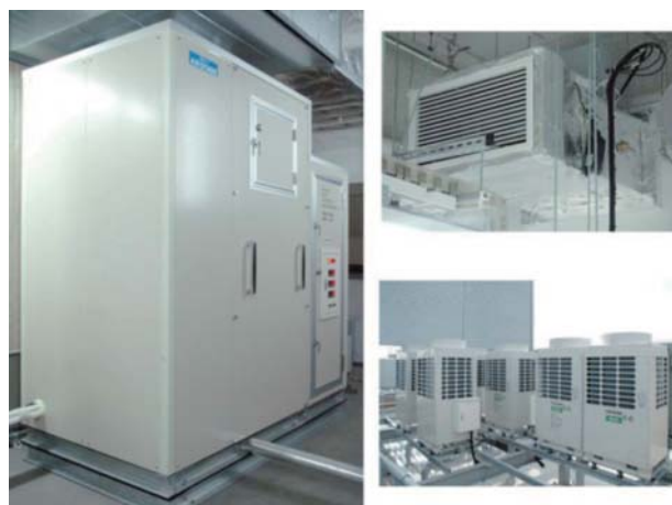
給気用 VAV エアコン
