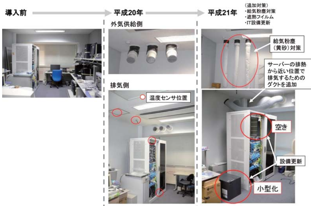
外気導入状況写真
