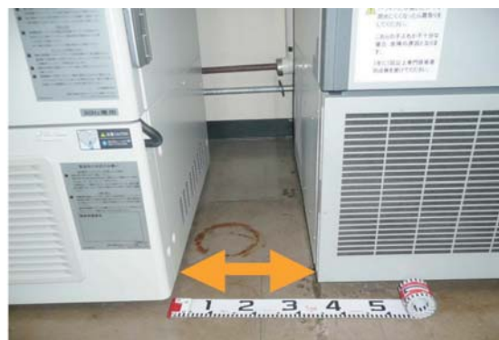
フリーザーの側面の隙間 (300mm)
