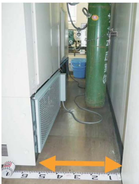
フリーザーの背面の隙間 (500mm)
